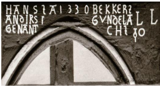
Großalmerode, Kleiner Berg 7: Ehemaliges Wohnhaus des ersten hessischen Gläserbundes Hans Becker, gnt. Gundelach andirs (siehe vorstehende Stammlinie Anna Gundelach unter 7.), mit Bauinschrift 1530, verfälscht „1330“
